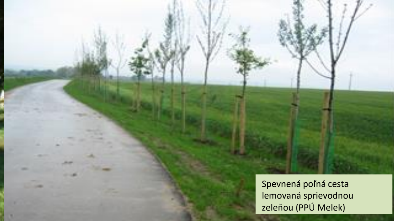
Poľná cesta sa stala miestom odpočinku a relaxu. Obyvatelia obce na betónových priepustoch osadili drevené lavičky (PPÚ Hankovce)
