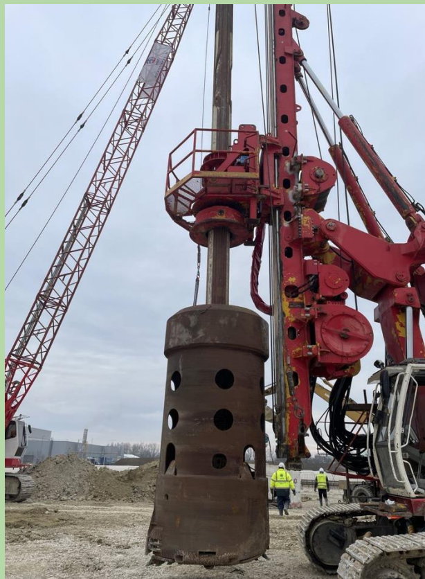
Talaj fúró / kitermelő (dob-fúró); Magas „testű” - segíti a függőleges fúrást Íránycsőből indulva!
